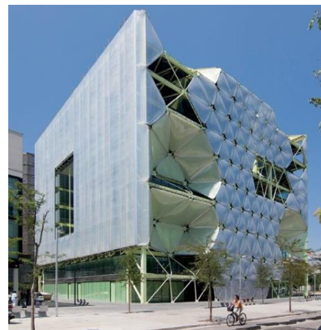
► Fig. 3: Pneumatic cells (Marysse, 2016)
